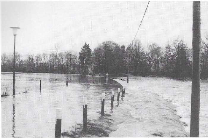
Schwer in Mitleidenschaft gezogen wurde der neue Fußweg zur Reckmühle. Er muß nun aufwendig ausgebessert werden.
