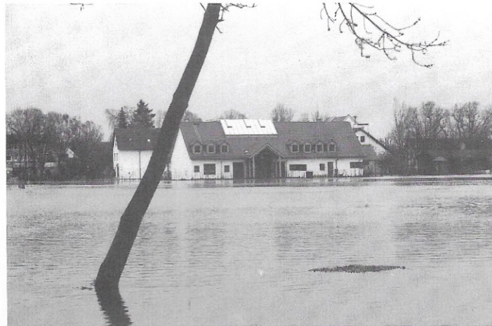
„Land unter“ hieß es für das Areal zwischen Glonn und Mühlbach. Die Kellerwanne des Kindergartens hielt stand, nur ein schlecht verdichteter Durchbruch der Telekom war schuld, daß Wasser eindrang und großen Schaden anrichtete
